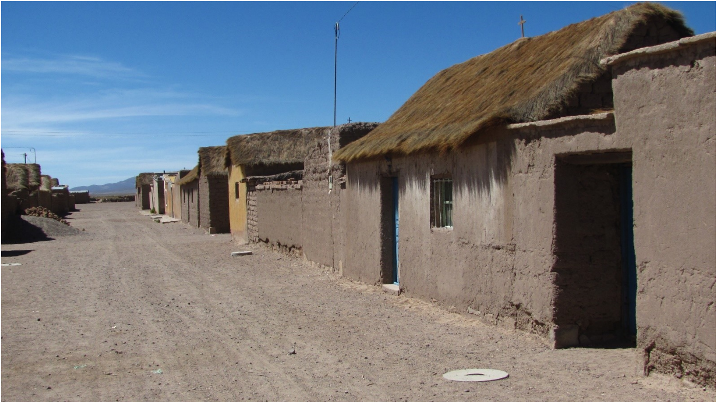
Foto 11: Domy z nepálených tehál (adobe) a strechy pokryté trávou mali obyvatelia Altiplana už pred príchodom Európanov (Petr Chalupa)
