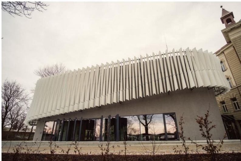
Přístavba výukového centra
