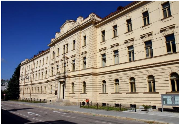
Budova VŠPJ, čelní pohled
